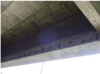
主桁：鉄筋露出
