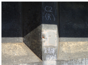
横桁：定着部の異常
