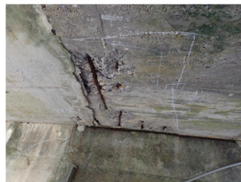
床版：鉄筋露出
