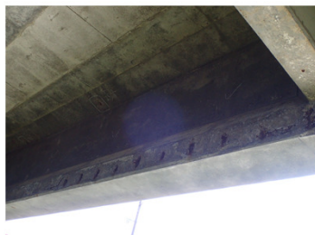
主桁：鉄筋露出
