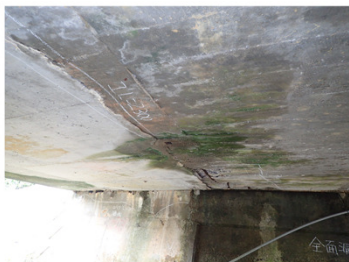
床版：遊離石灰(モルタルジョイント)
