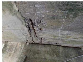
床版：鉄筋露出
