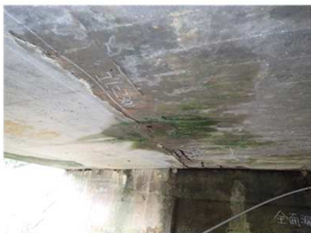
床版：遊離石灰(コールドジョイント)
