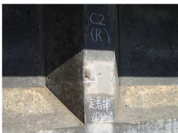
横桁：定着部の異常
