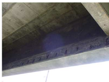
主桁：鉄筋露出
