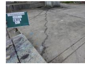
陸上目視状況
