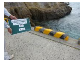
陸上目視状況
