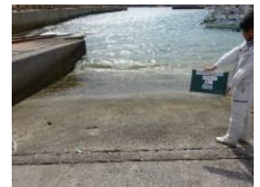
陸上目視状況
