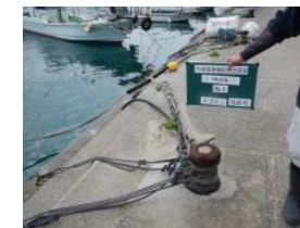
陸上目視状況
