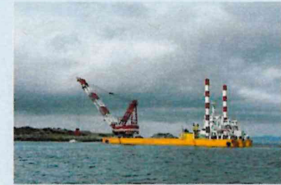
基礎捨石工事
