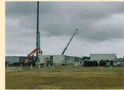
仮設宿舎工事
