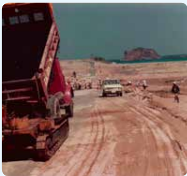
昭和49年頃 工事の様子
