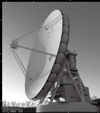
美笹局の直径54m大型パラボラアンテナ
