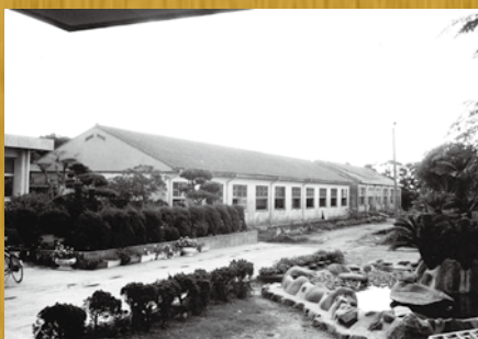
長谷小学校旧校舎 （昭和 62 年撮影時の校舎）
