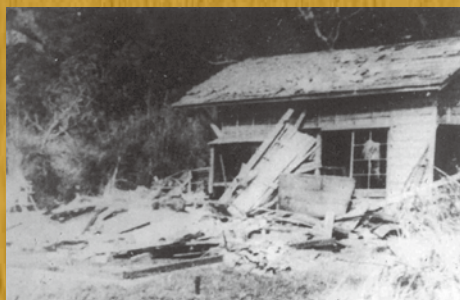
大きな被害を受けた荃永の公営住宅 （昭和29年台風15号・洞爺丸台風）
