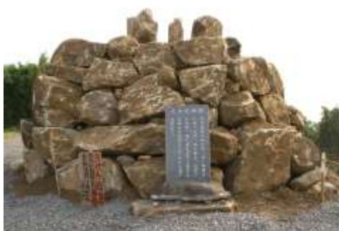
完成したのろし台
