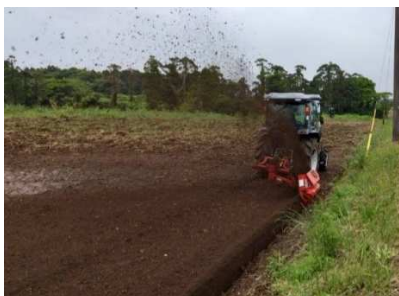
額縁明渠設置
